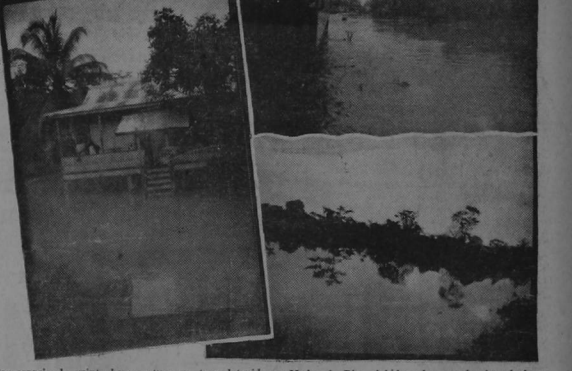
Por espacio de veinte horas estuvo un tren detenido en Madre de Dios, debido a las grandes inundaciones del caudal del río. Los fotos que ofrecemos, enviadas por nuestro activo redactor señor de la O Miranda, recorren dos aspectos de la inundación en Estrada y a la derecha, superior, el tren detenido cerca de Madre de Dios.
